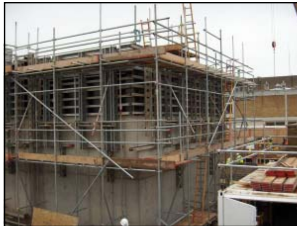
LINAC roof slab ready for concrete pour
