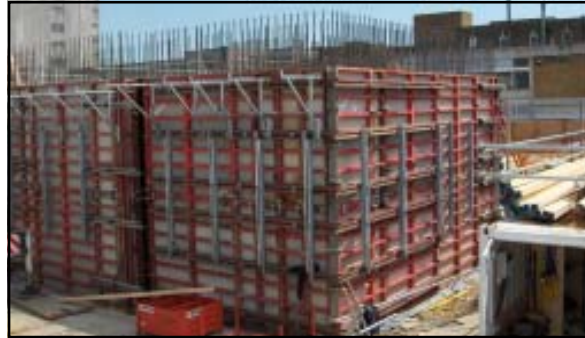
LINAC walls ready for concrete pour
